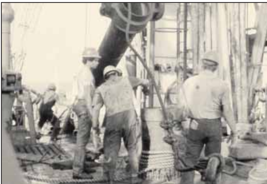
Fig. 3-29. Faenas de manipulación e inserción de un revestidor en el hoyo.
