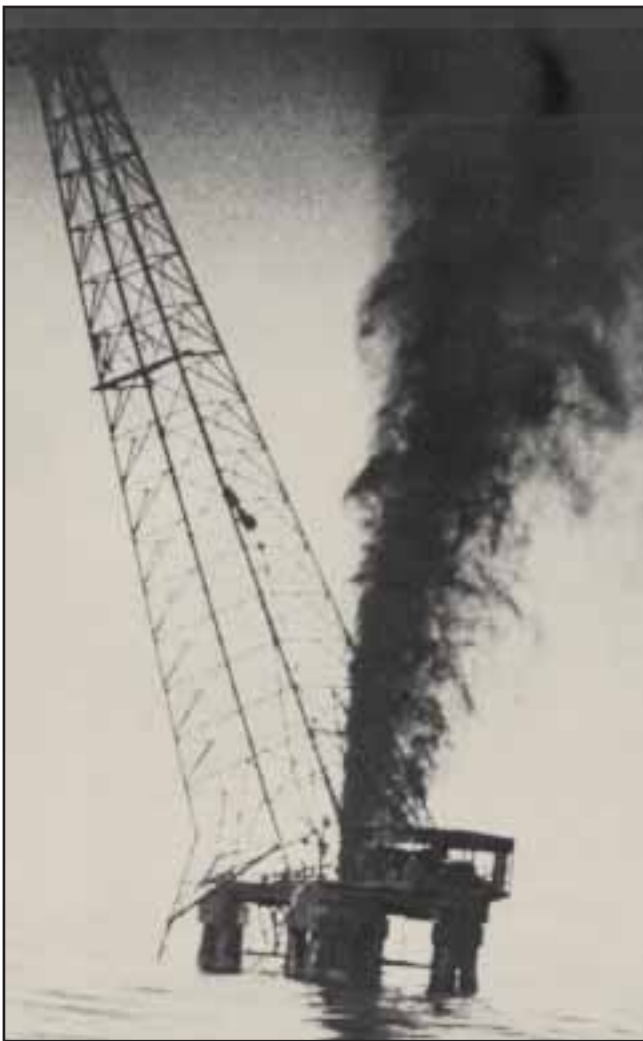
Fig. 3-39. Espectacular reventón de un pozo en el lago de Maracaibo.
