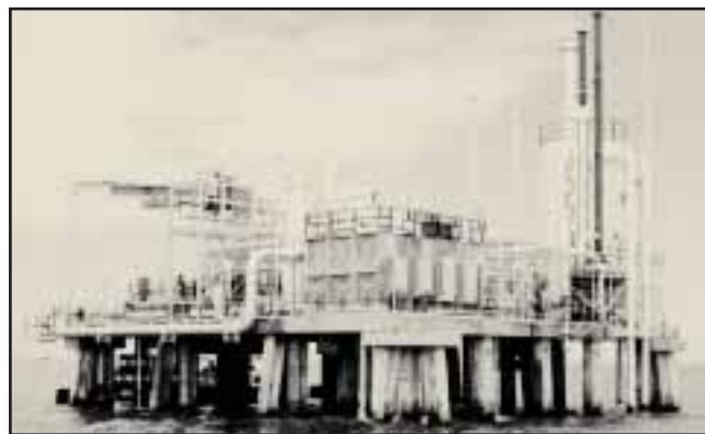
Fig. 5-1. Ejemplo de instalaciones lacustres para manejar gas natural asociado, producido de yacimientos en el lago de Maracaibo.
