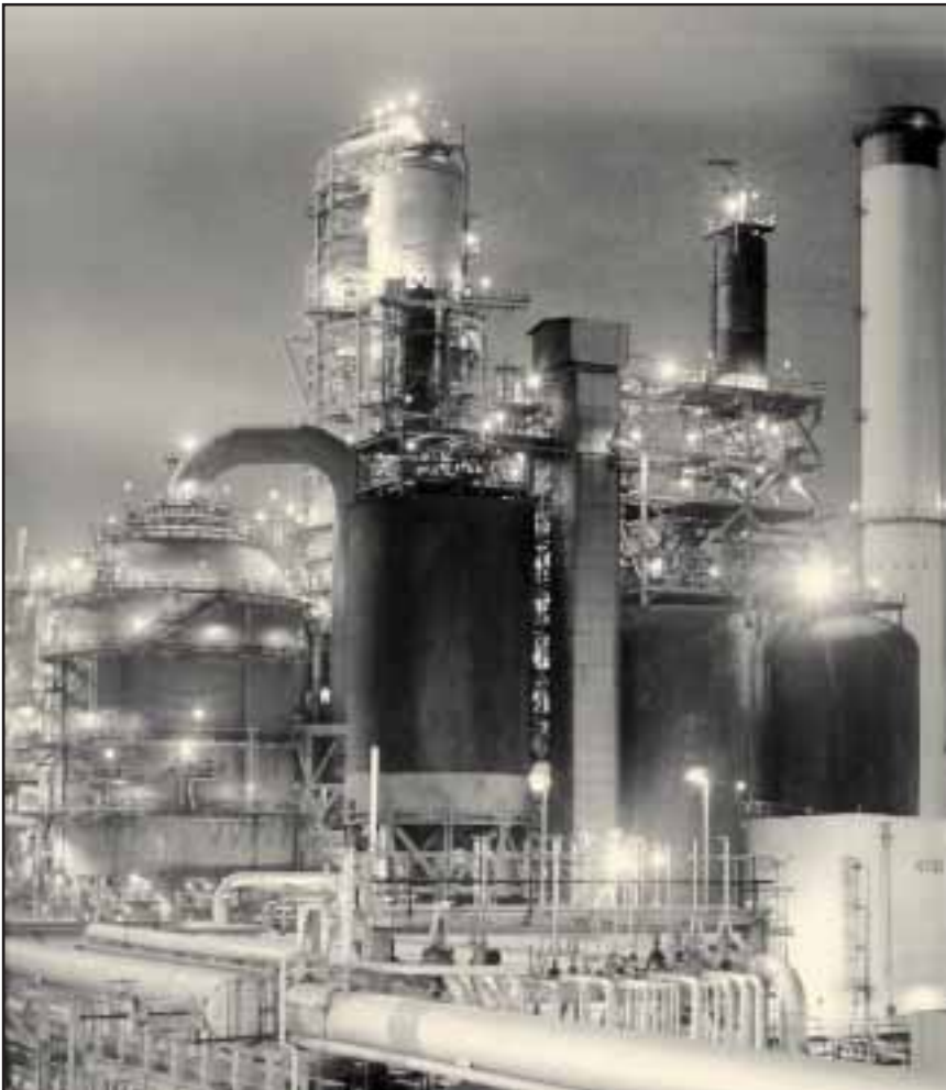
Fig. 6-2. Vista parcial del Centro de Refinación Paraguaná y sus complejas instalaciones.
