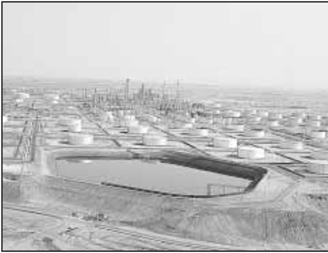
Fig. 6-43. Vista parcial del extenso sistema de almacenamiento para crudos y productos, formado por tanques y un embalse de gran volumen.
