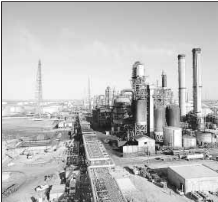
Fig. 6-36. Vista parcial de las instalaciones del complejo de cambio de patrón de refinación, en Amuay, Centro de Refinación Paraguaná, estado Falcón.
