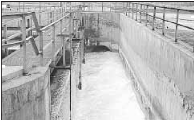
Fig. 6-14. El manejo y el uso del agua son actividades esenciales en la refinería.
