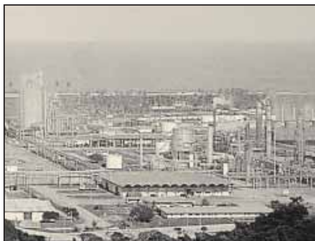
Fig. 7-9. Vista parcial del complejo petroquímico Morón.
