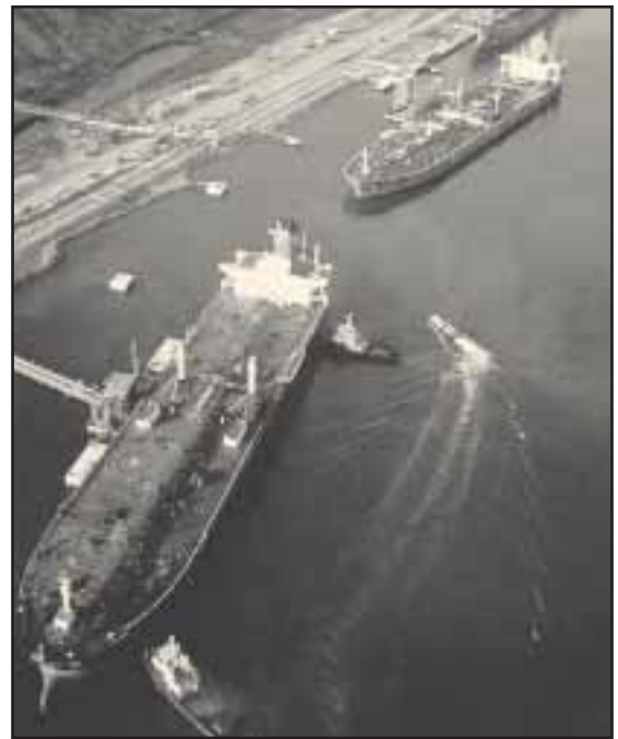
Fig. 8-15. La separación del gas del petróleo y el posterior tratamiento de cada sustancia permiten que el petróleo sea entregado a los tanqueros en las terminales de embarque. El gas, como líquido, es embarcado en buques cisterna llamados metaneros, de características especiales.
