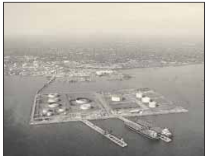
Fig. 8-32. Terminal de La Salina, lago de Maracaibo.
