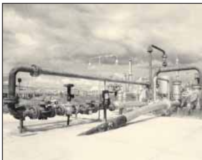
Fig. 8-13. En los sitios de entrega de grandes volúmenes diarios de gas se cuenta con instalaciones de medición y control de la eficiencia de las operaciones.
