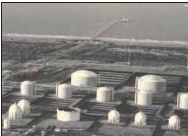
Fig. 8-21. Instalación de almacenamiento de líquidos del gas natural en Jose, estado Anzoátegui.
