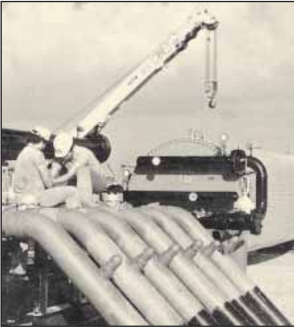
Fig. 8-14. La mezcla de gas y petróleo producida en el campo es llevada por tubería desde el cabezal de cada pozo hasta una estación de separación y recolección.
